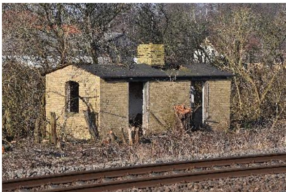
Efter rydning af bevoksning er dette lille hus – måske et udhus til et nedrevet ledvogterhus, måske et kolonnehus, dukket op ved Sværdborg Lu-Vo , foto mandag 18. februar 2019 .
